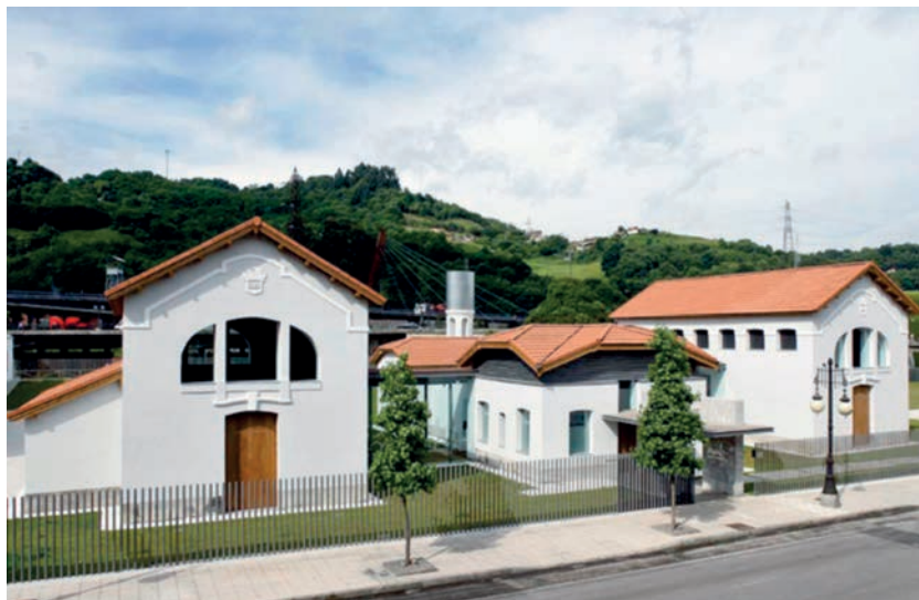
Figura 5. Pinacoteca Eduardo Úrculo, estado actual. Fotografía de la autora.
